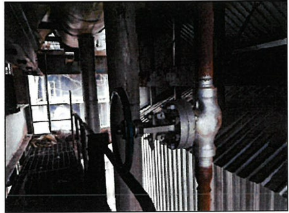
วาล์วระบายน้ำออกจากหม้อไอน้ำ (Blow down Valve)
