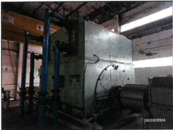
รูปที่ 24 การปิดครอบเครื่องจักรอุปกรณ์ที่มีเสียงดัง
