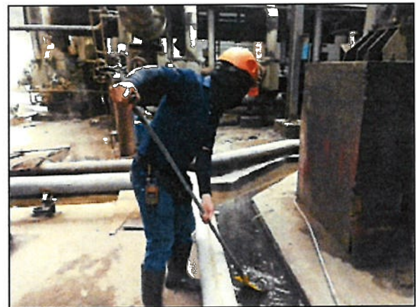
รูปที่ 25 รางระบายและการทำความสะอาดรางระบายน้ำฝนของโครงการ
